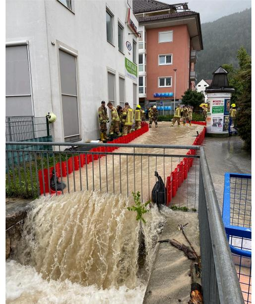
Der Noaq Boxwall ist ein freistehender mobiler Hochwasserschutz, speziell entwickelt für den Einsatz im städtischen Bereich, auf harten und ebenen Oberflächen, wie Asphaltstraßen und Beton. Er funktioniert aber auch auf Rasen etc.
